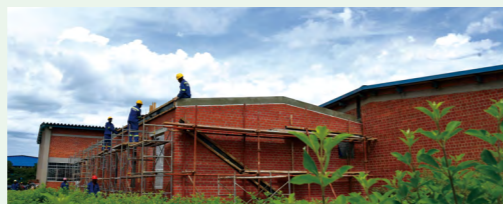
建设中的新办公室
