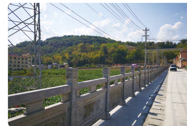
易地搬迁集中安置点高位挡墙护栏
