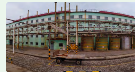
综合回收分厂浸出车间外景
