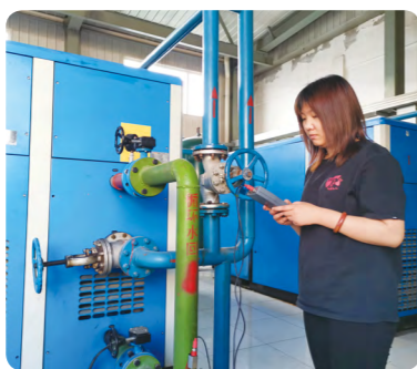
天津市水务局委托专门机构检测人员在中色特材水泵站进行水平衡测试
