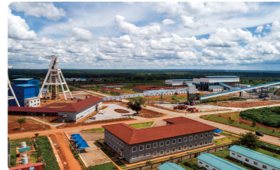
中色非矿谦比希铜矿东南矿区选冶工程项目为建成非洲自动化样板矿山、提升矿山竞争力提供有力保障
